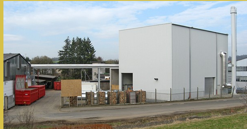
Abb. 2: Industrieheizwerk (Quelle: Homepage des Betreibers)
